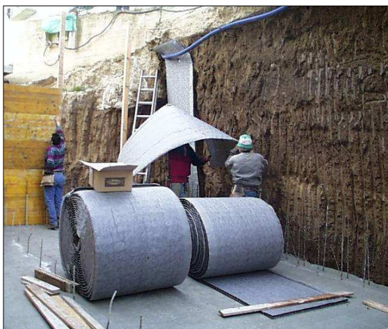
Esempio di posa dell'Enkadrain® sul fronte di scavo
