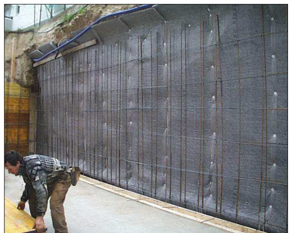
Esempio di posa dell'Enkadrain® sul fronte di scavo
