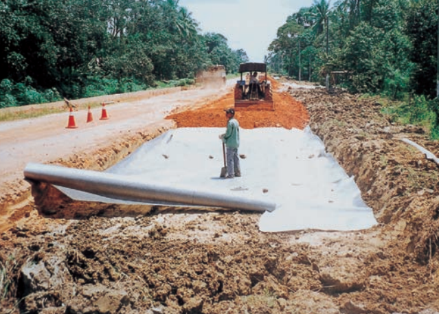
Costruzione di una nuova strada (Malesia)
