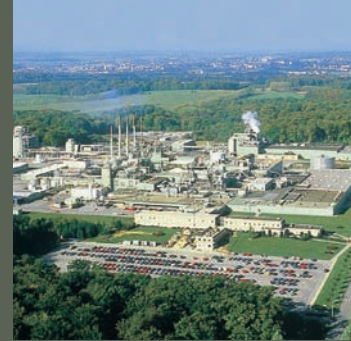
Impianto produttivo (Lussemburgo)
