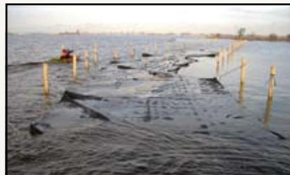
TenCate Geotube® posizionati e fissati temporaneamente prima di procedere al riempimento.
