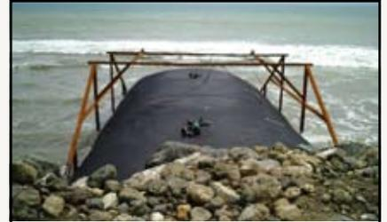
TenCate Geotube® tenuto in posizione da una gabbia metallica per assicurare una posizionamento preciso
