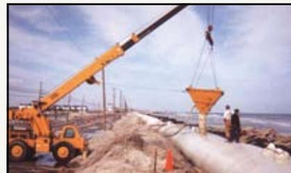
Metodo Hopper per il riempimento dei TenCate Geotube®
