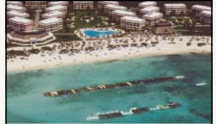
TenCate Geotube® utilizzati per realizzare un frangiflutti sommerso
