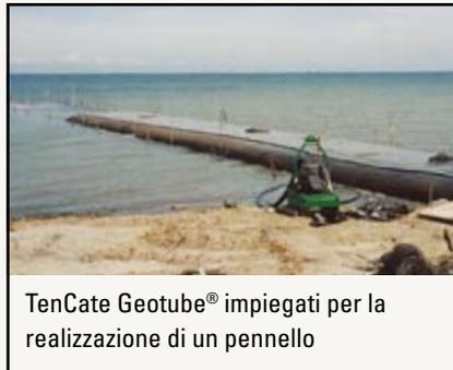
TenCate Geotube® impiegati per la realizzazione di un pennello
