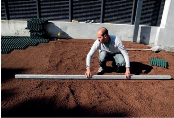
Staggiatura dello stato di allettamento in lapillo
