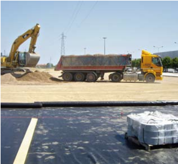
Piste da cantiere
