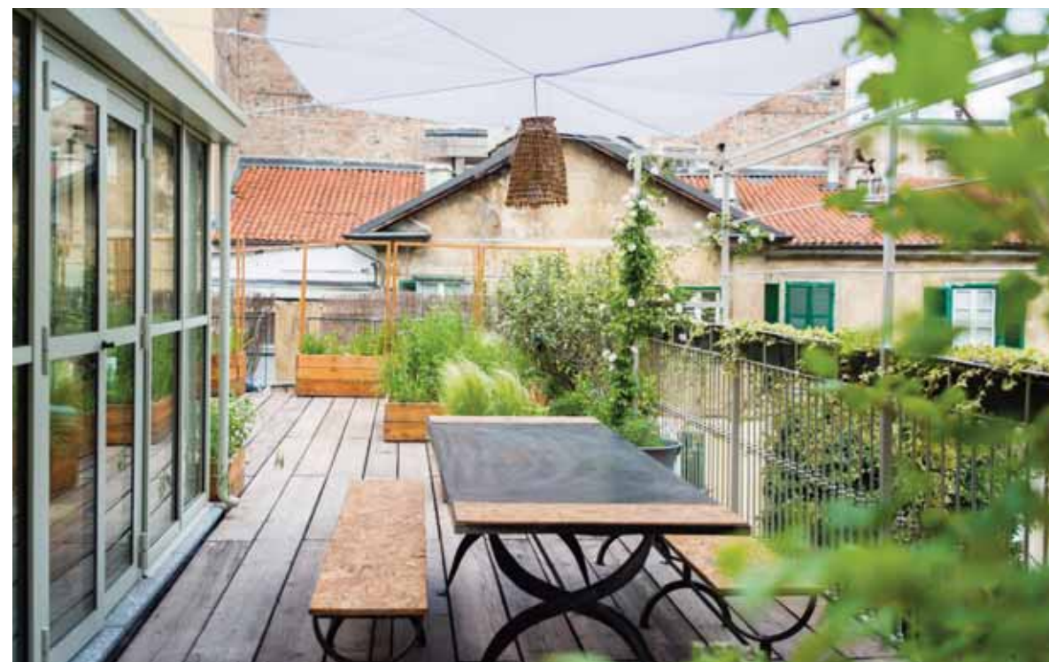
Su tutta la superficie, pavimentazione in assi da cantiere di seconda mano, trattate con vernici per esterno.
