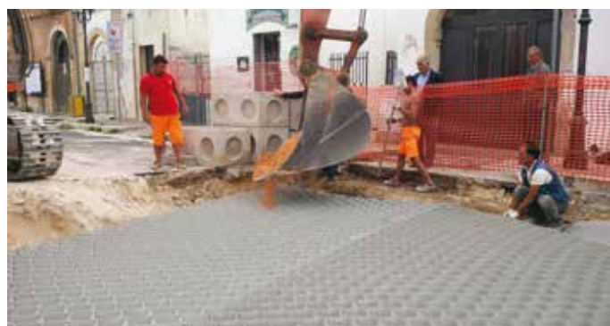
4 e 5. Il riempimento del sistema PRS-Neoweb
