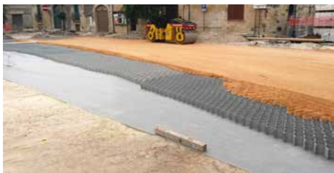
6. Un dettaglio della base stabilizzata Prs-Neoweb
