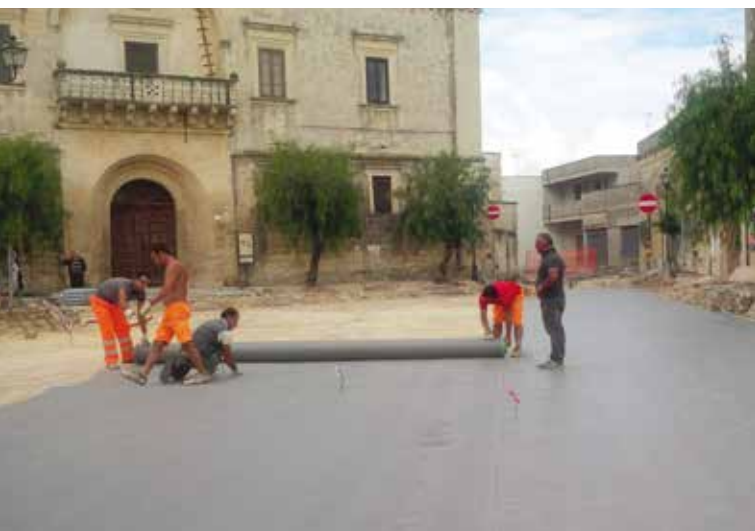
1. L'installazione del geocomposito Enkagrid TRC
