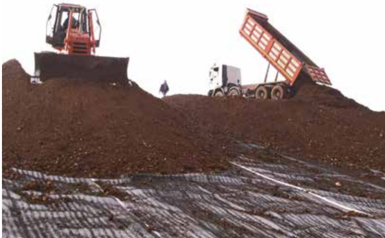
Copertura definitiva discarica di rifiuti non pericolosi – Castenedolo (BS)
