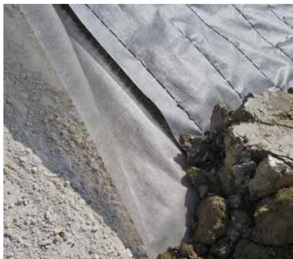
Copertura definitiva discarica di rifiuti non pericolosi – Brindisi (BR)
