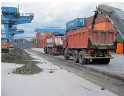
Scarifica della pavimentazione esistente
