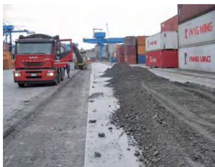
Scarifica della pavimentazione esistente
