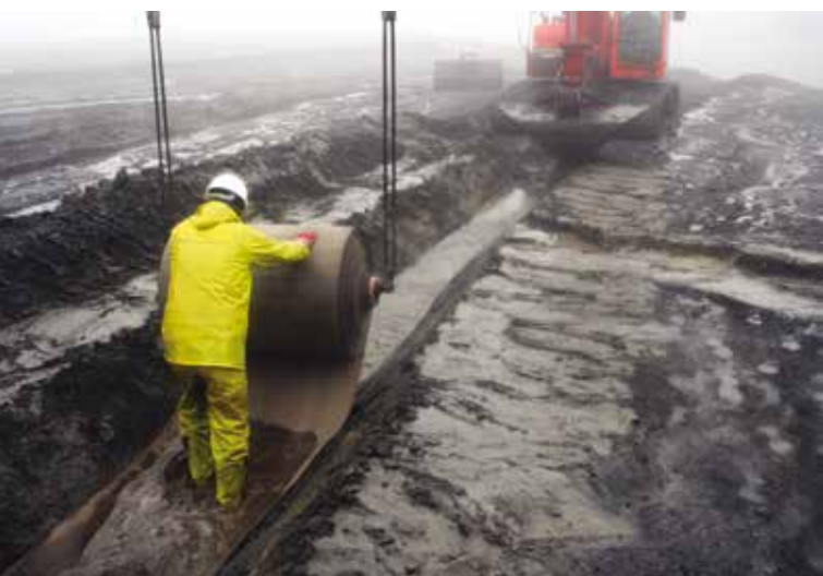
1. La posa con presenza d'acqua
