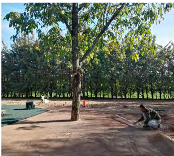
Fase di posa delle piastre
