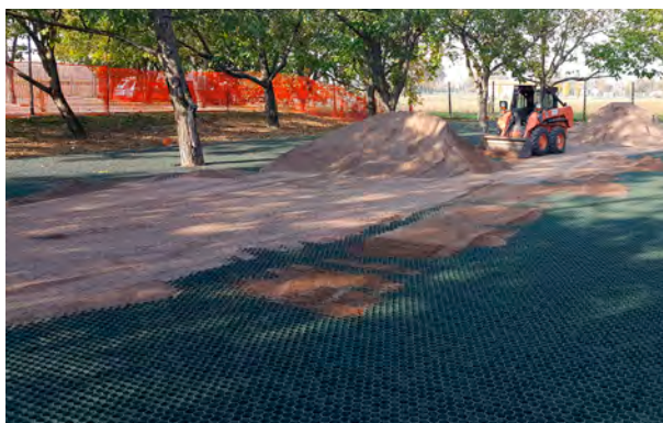
Fase di riempimento degli alveoli
