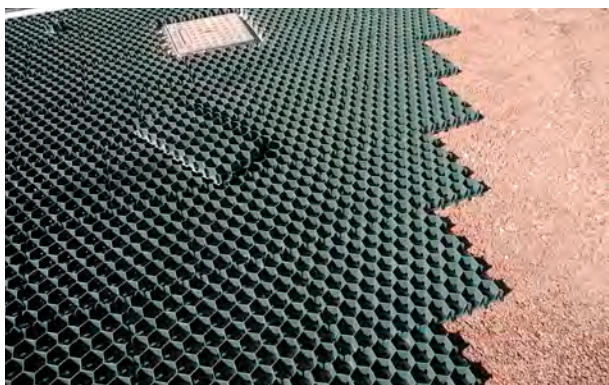
Fase di posa delle piastre
