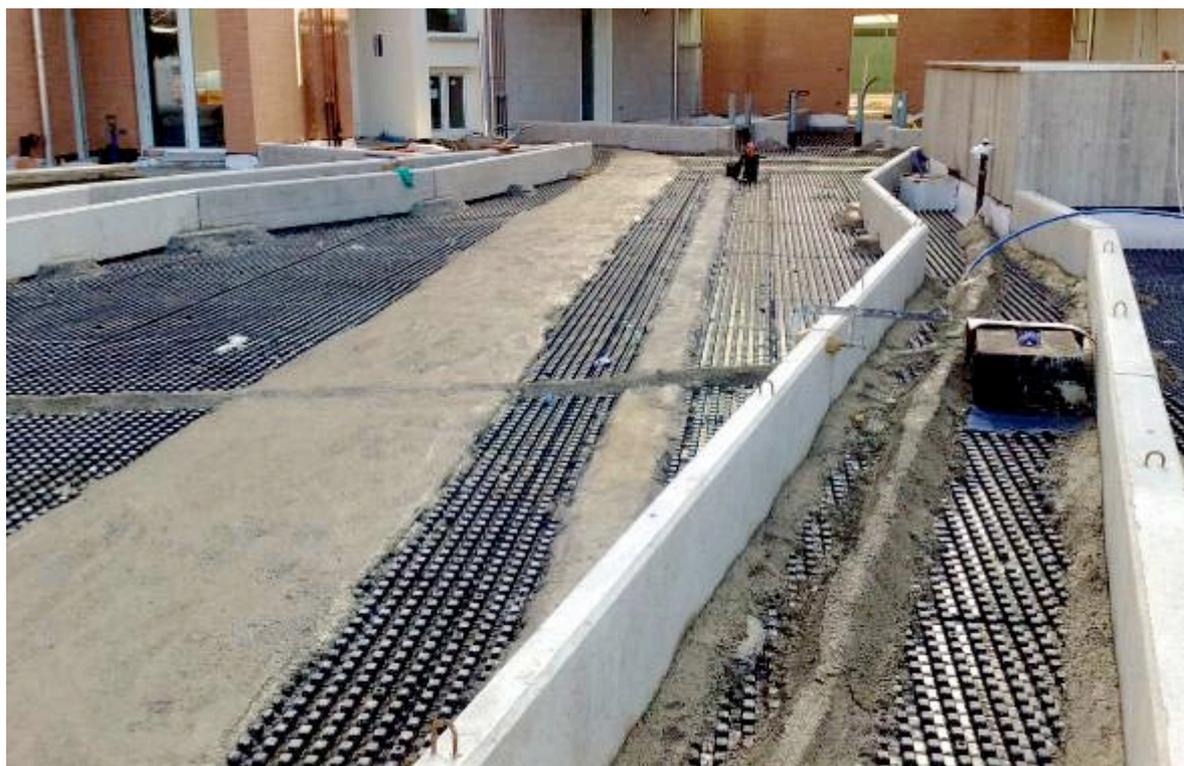
Immagini relative alla realizzazione di muretti confinamento aree verdi/aree pavimentate realizzati su nostro drenaggio MediDrain MD
