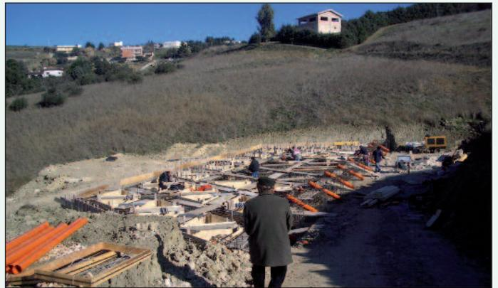
Figure 8 - La costruzione del graticcio di fondazione della zona centrale
