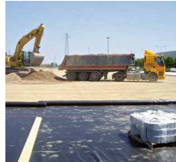
Piste da cantiere
