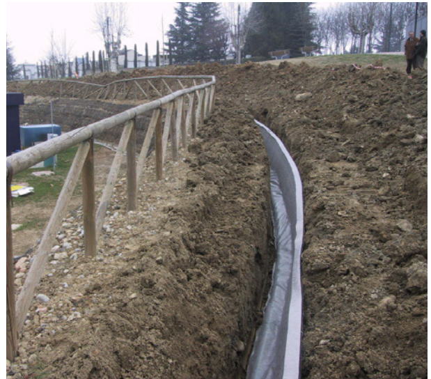
Posa del geocomposito nello scavo
