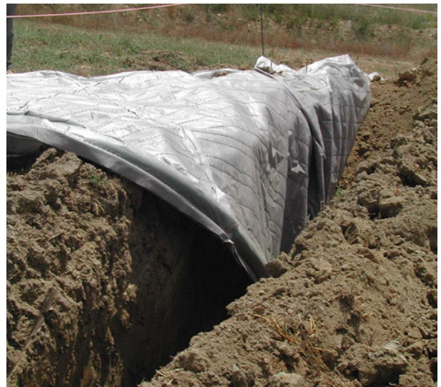
Posa del geocomposito e ritombamento della trincea drenante
