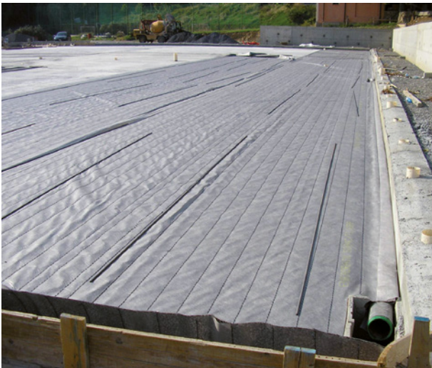
Posa ultimata con tubazione di drenaggio
