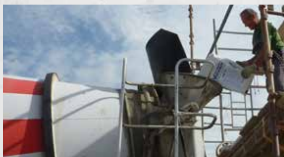
VANDEX AM 10 va aggiunto presso lo stabilimento di miscelazione
