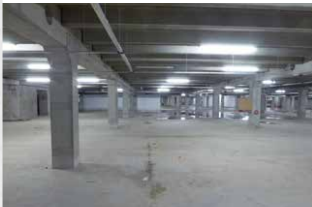
Scantinati e fondazioni in calcestruzzo
