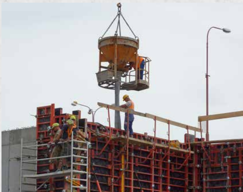
Versamento del calcestruzzo
